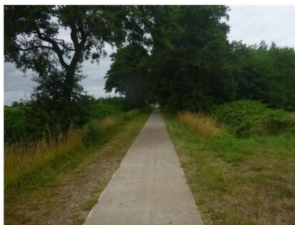
Fietspad Maisweg met puin in berm
