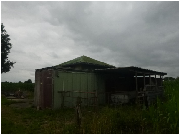
Schuurtje Sikkelweg metalen profielplaten
