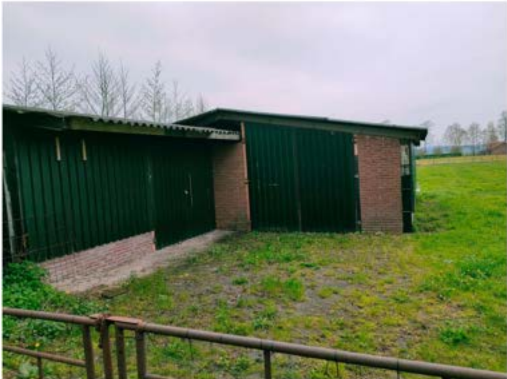
2. Maisweg, Schuur, opgetrokken uit bakstenen en damwandprofielen muren, gedekt met golfplaten.
